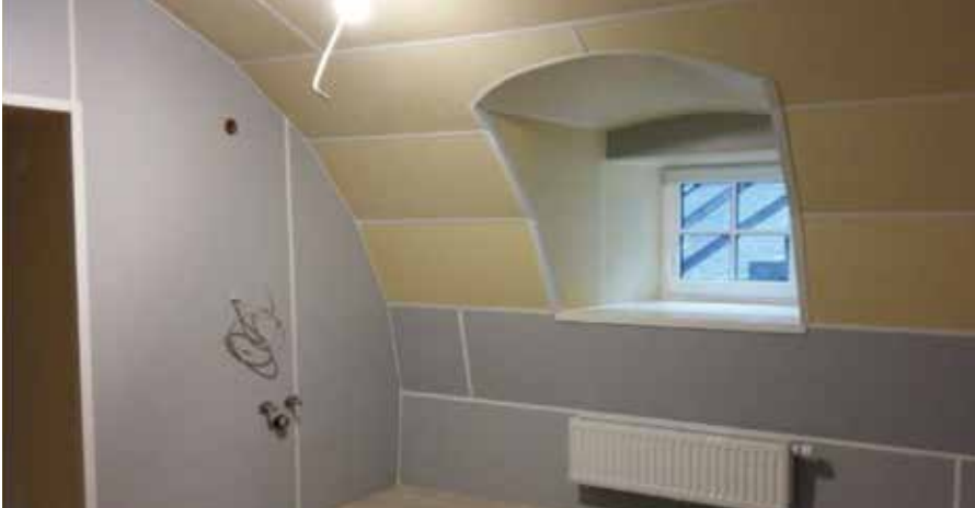
SGP – Sanierungs Großfliesen-Platten direkt über alte Fliesen geklebt in Privat- und Wirtschaftsküche mit Deckenpaneel
