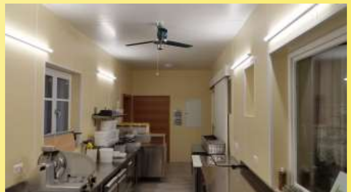
SGP – Sanierungs Großfliesen-Platten direkt über alte Fliesen geklebt in Privat- und Wirtschaftsküche mit Deckenpaneelle
