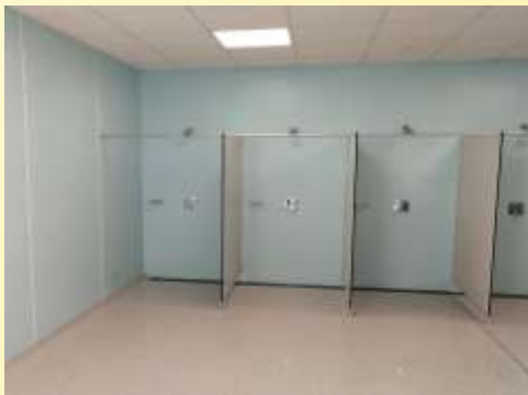
Dusch- und Waschräume glatt, pflegeleicht, fugenfrei;
