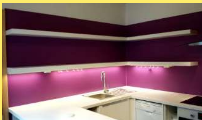
Küche: Wand, Decke, Küchenrückwand abwaschbar, fugenlos
