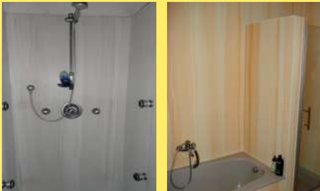
Sanierung Bad-WC - auch direkt über alte Fliesen
